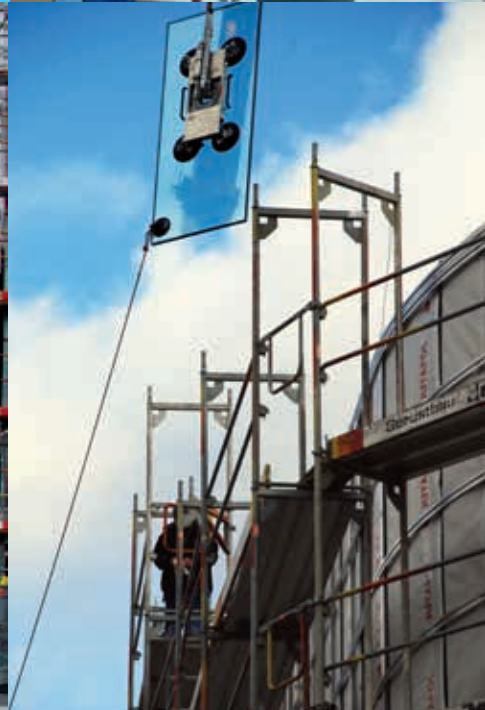
epplerfenster Einbau der Fensterverglasung
