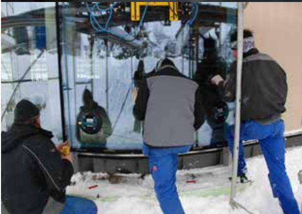
Montage Präzise Montagearbeiten mit Spezialglassauger für gebogene Scheiben unter erschwerten winterlichen Bedingungen.
