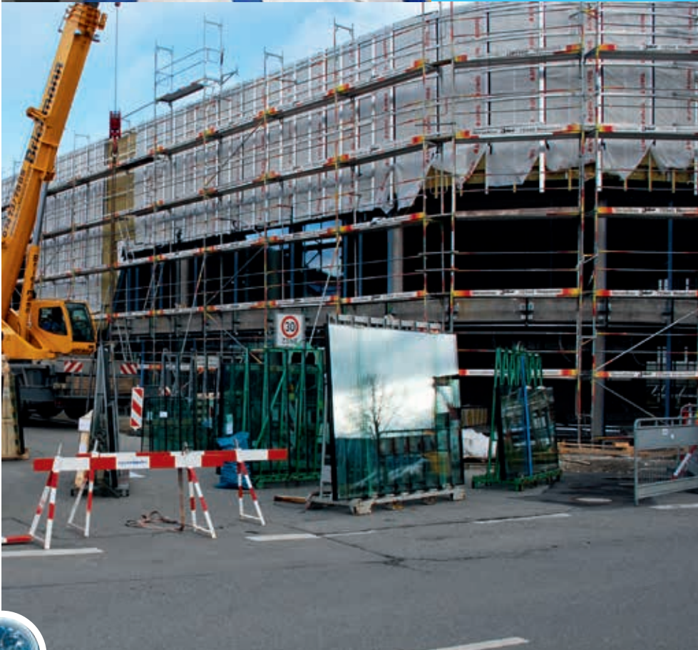
epplerfenster Einbau der Fensterverglasung
